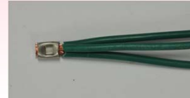
以短套管壓接
