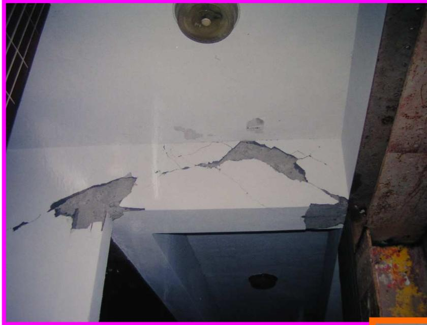
■非結構牆效應造成之短梁剪力破壞現象
