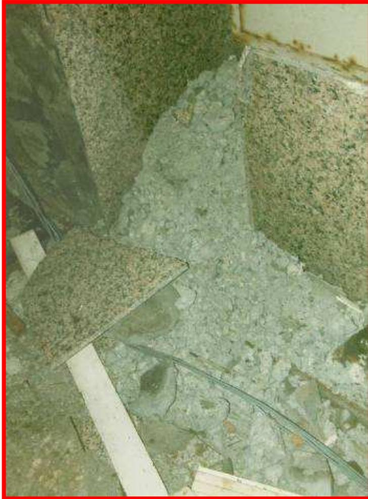
■ 混凝土中飛灰. 爐石添加過多，抗壓強度不足
