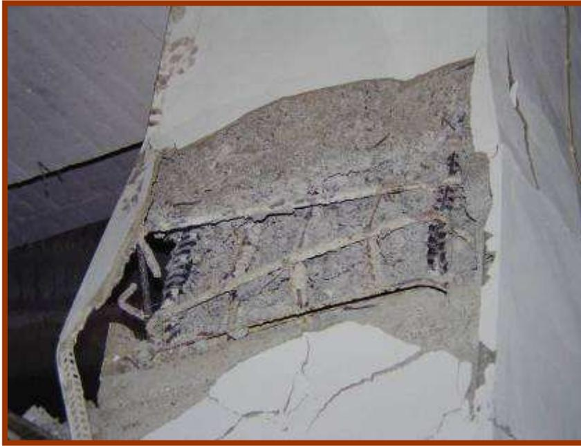
■柱箍筋未施作  $135^{\circ}$  彎勾，未施作輔助箍筋
